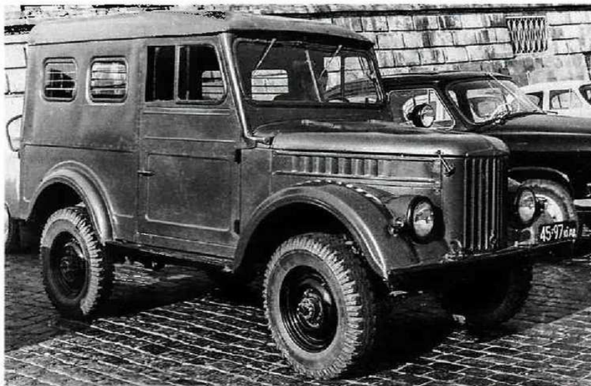
Милицейский ГАЗ-69 с зарешеченными окнами заднего отсека
