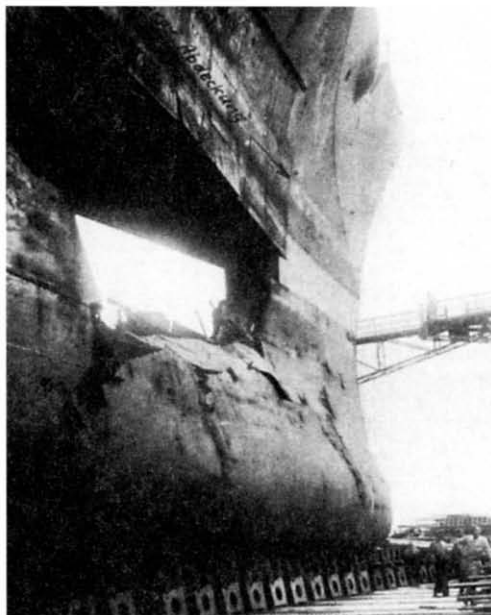
«Гнейзенау» в доке завода «Ховальд Верфт» в Киле, август 1940 г. Хорошо видна часть временной заделки торпедной пробоины, выполненной в Тронхейме
