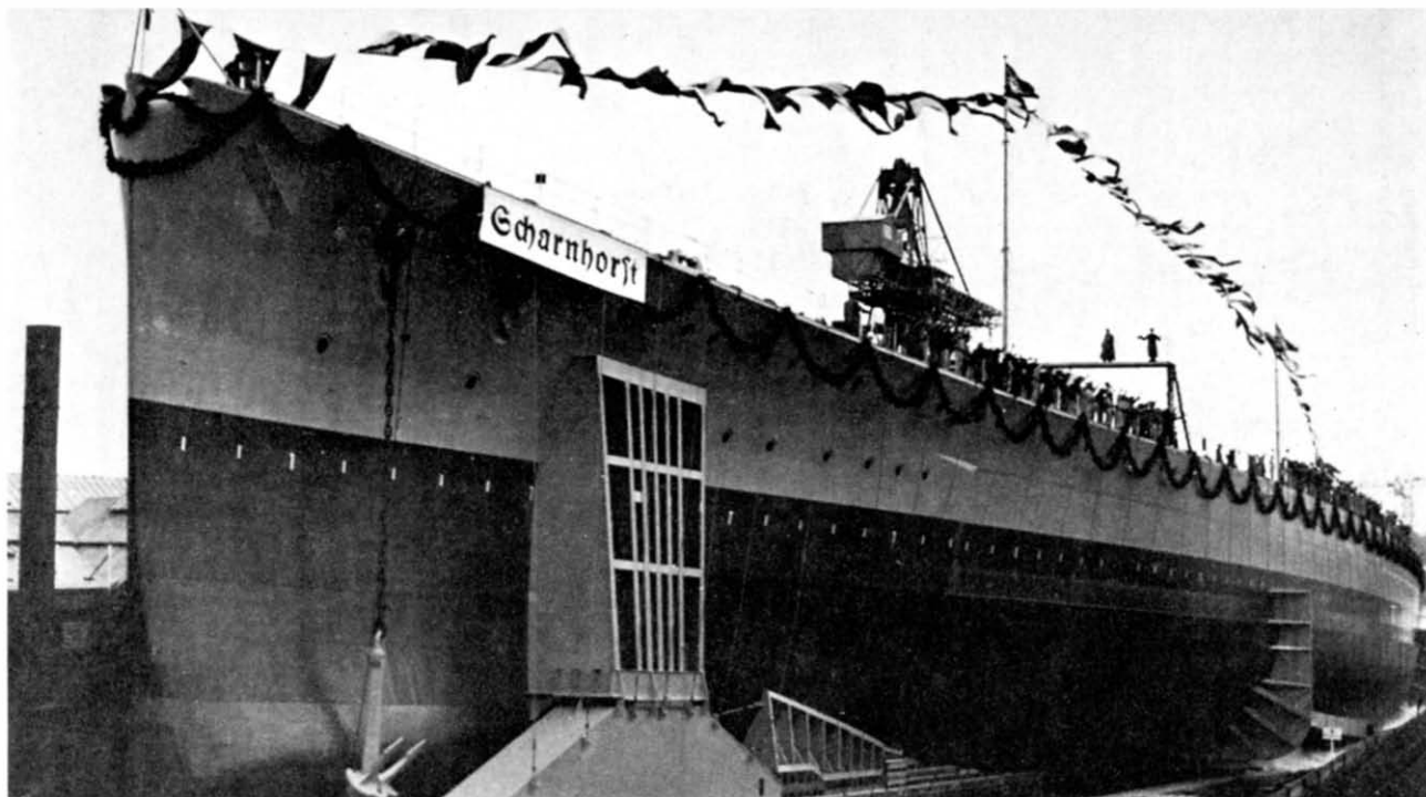
«Шарнхорст» перед спуском на воду, 3 октября 1936 г. Хорошо виден носовой бульб, предназначенный для снижения волнового сопротивления
