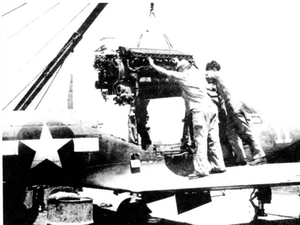
Замена двигателя V-1710 на полевом аэродроме Таджи, Новая Гвинея, август 1944 г.
